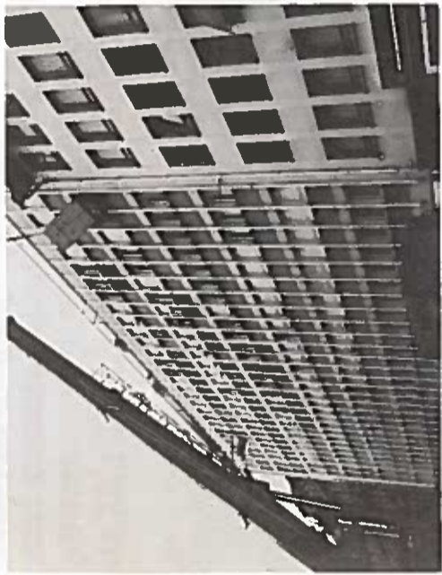
Tombera, tombera pas !... Rassurez-vous la corde est solide, fini les fléaux d'acier ! Désormais, on se sert de cordes de lin, avec un diamètre d'environ 5 cm, on peut prendre plusieurs tonnes, facile à transporter, à enrouler, et sans danger pour les mains et les meubles. C'est bien le progrès !...
